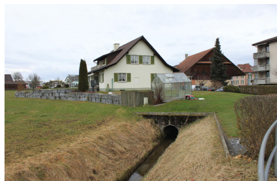
Abb. 5: Dorfbach Ettiswil Abs. 1, Blickrichtung Norden, Schwachstelle eingedolter Bereich
